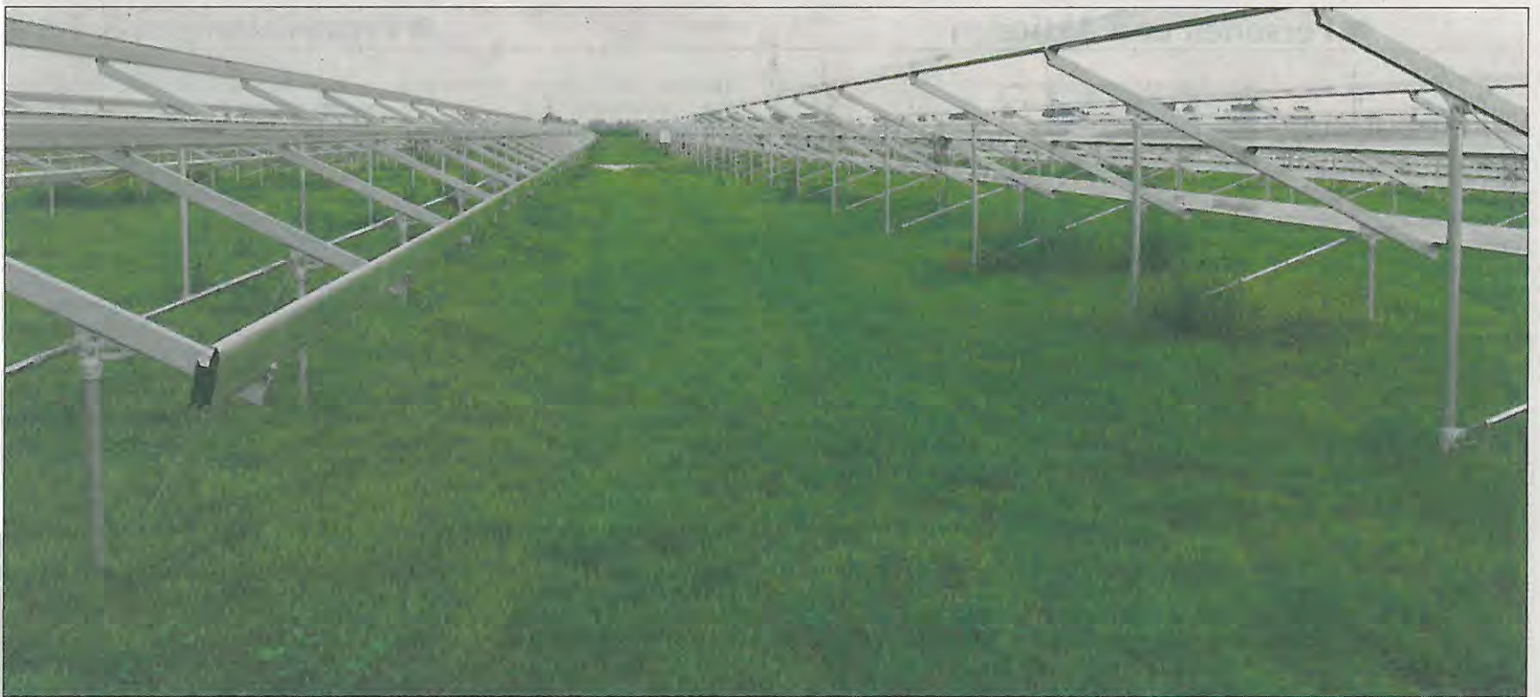
Die Bürgersolaranlage, die derzeit in Straßkirchen/Gänsdorf gebaut wird, umfasst eine Fläche von zehn Hektar und hat eine Leistung von vier Megawatt. (Foto: usa)
